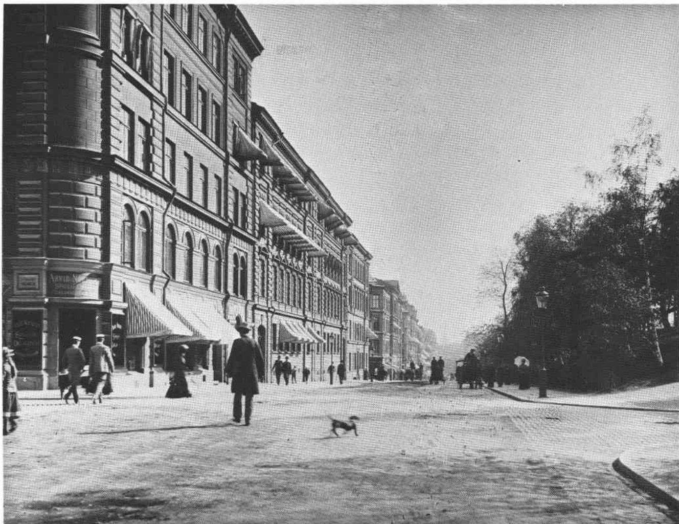
Sturegatan söderut från hörnet av Karlavägen. Hörnhuset har rundat hörn och är 5 vån högt enligt den nya byggnadsordningen medan husen längre ner på gatan endast är uppförda i 4 vån. C O Lundberg var byggherre till hörnhuset, vilket rymde både Arvid Nordquists speceri- och delikatessaffär och Carlssons skola. Huset revs på 1960-talet.
